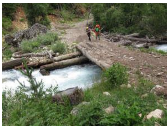
Рисунок 37. Мост через р. Джалпакол.
